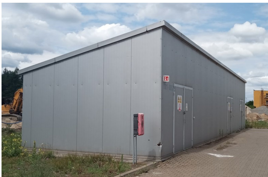
Zdjęcia – budynek magazynowy
